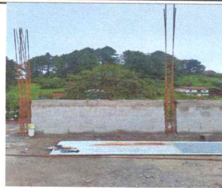
Foto 2: Preparación del área a mejorar.
