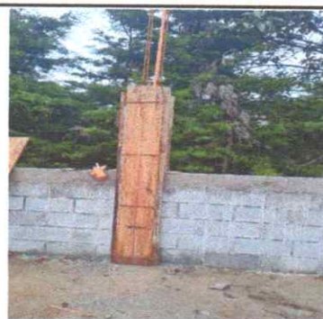
Foto 6: Fundición en proceso de finalización.
