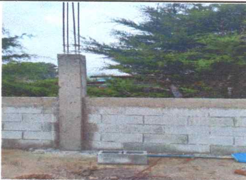
Foto 3: Mejoramiento de paredes en aulas.
