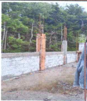
Foto 5: Mejoramiento de paredes en aulas, fundición de columnas en aulas a mejorae.
