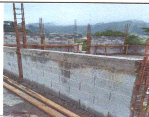
Foto 4: Área de terreno a mejorar.
